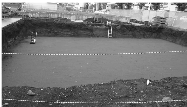
図3 建築物の建て替え現場(東京都町田市)。写真中央の均された部分は建物の基礎となる。
