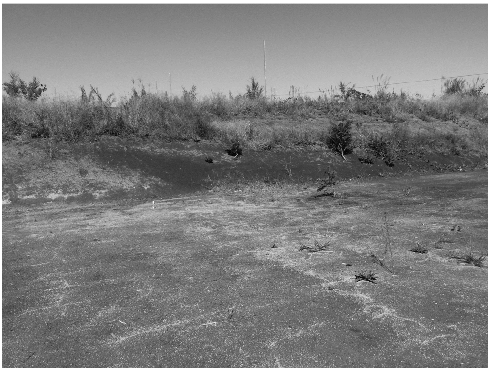
図1 つくば市の宅地造成現場。手前側が切土面、奥側が盛土法面。元の表土が造成過程で斜面に沿って移動堆積が法面の状況から確認できる。
